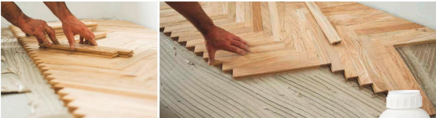
Elakol 2K PUR dvokomponentno poliuretansko lepilo bez vode i bez rastvarača za polaganje svih vrsta parketa na upijajuće (beton, cementni estrih) i neupijajuće (keramika, prirodni i veštački kamen, metal) podlove. Lepilo je pogodno za estrihe sa većim procentnom vlagom i površine sa podnim grejanjem.
